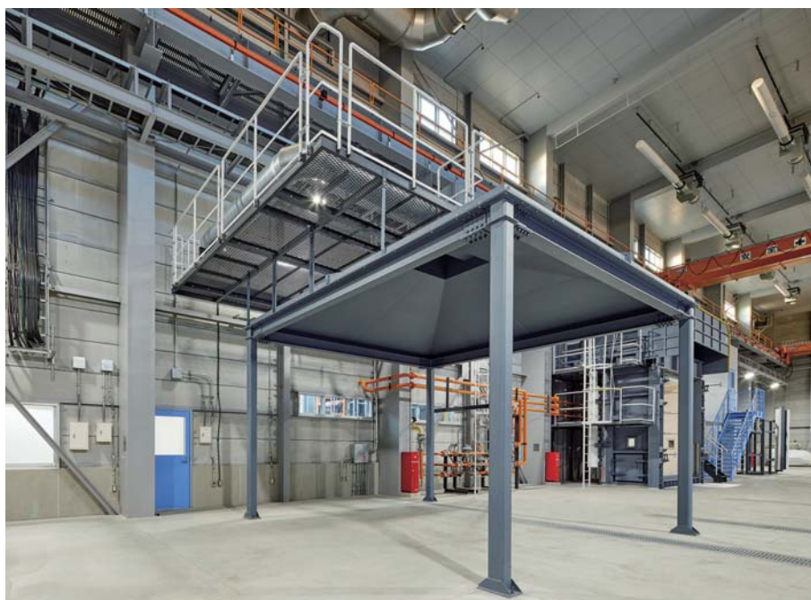
多目的試験場
