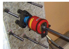
あと施工アンカーの引張試験
