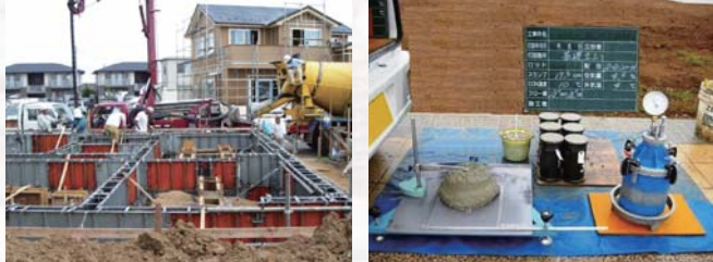
コンクリート打設現場での供試体採取
