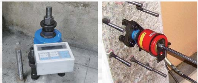
あと施工アンカーの引張試験
