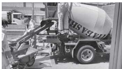
写真-10 フレッシュコンクリートの採取
