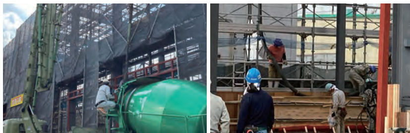
写真6 ポンプ圧送状況
