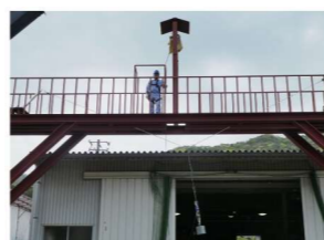
■現場での仮設機材の試験 親綱支柱の試験に対応
