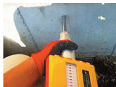
リバウンドハンマーによる 圧縮強度推定試験
