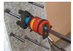
あと施工アンカーの引張試験
