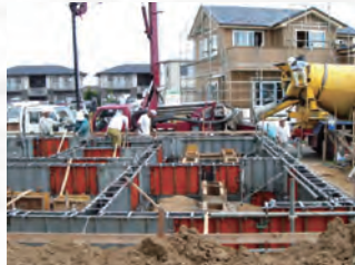
コンクリート打設現場での供試体採取
