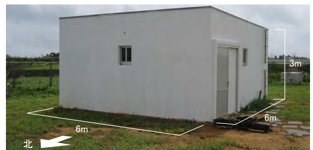
写真4 建設した観測建物（この屋上に試験防水層を敷設）
