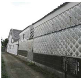
写真1 なまこ壁（松崎・近藤家）
