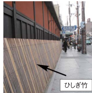
外壁材の保護資材
