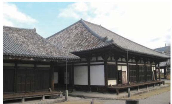
写真1 奈良・元興寺の瓦葺屋根
