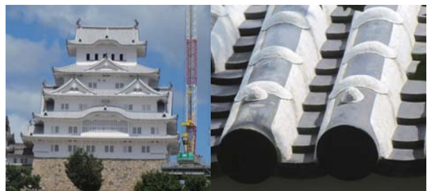
写真3 本瓦の漆喰目地（姫路城）
