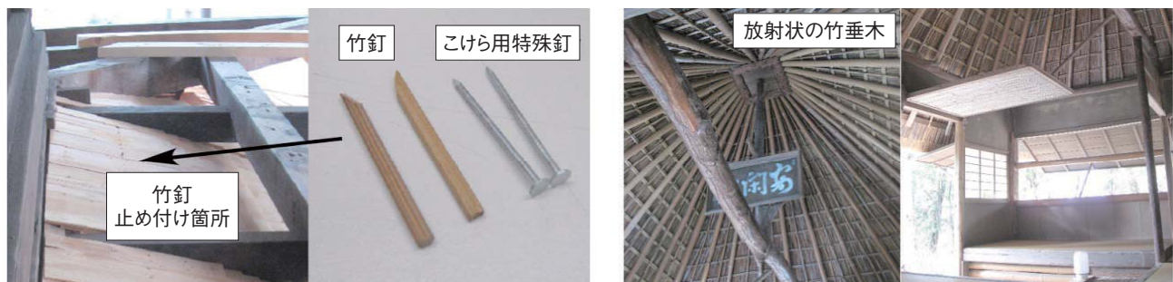
銀閣寺・平成大改修時の柿葺き止め付けに使用した竹釘
