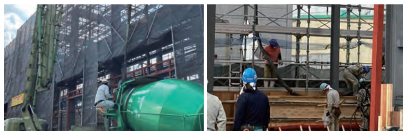
写真6 ポンプ圧送状況
