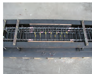
写真3 コンクリートを打ち込む前の 鉄筋骨組および型枠（試験体）
