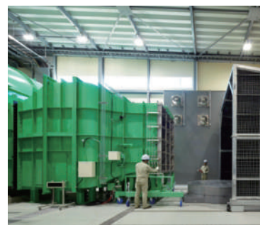
大型送風散水試験装置
