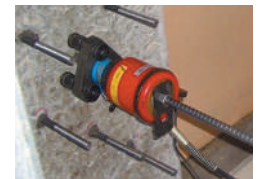
あと施工アンカーの引張試験
