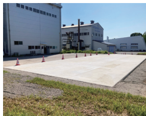
■ コンクリート打設場所（屋外） アンカー用母材コンクリートの打設に対応
