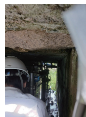
■現場測定試験 既設構造物の現場 調査・たわみ量測定
