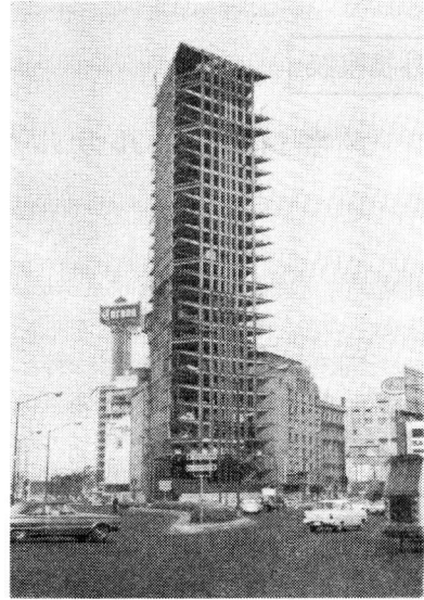
写真一 3 建設中の高層ビル
