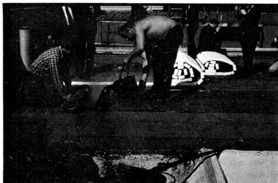
写真-6 フォームスチレン付ルーフィングを用いている現場
