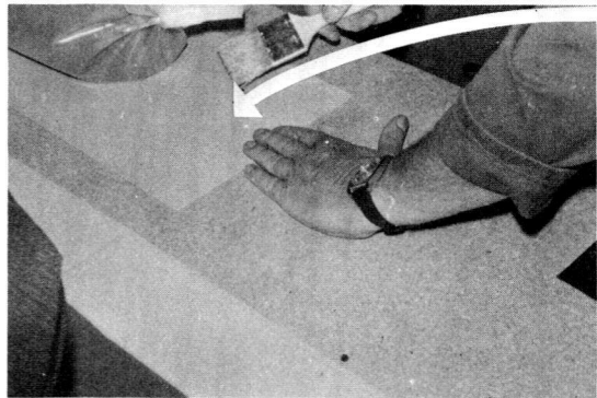
写真-13 乾質塩化ビニルシートを用いる防水工法 (Dynamit Nobel社)
