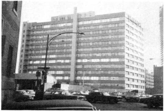
写真-6 NFPAの建物遠望(左方が海岸側)
