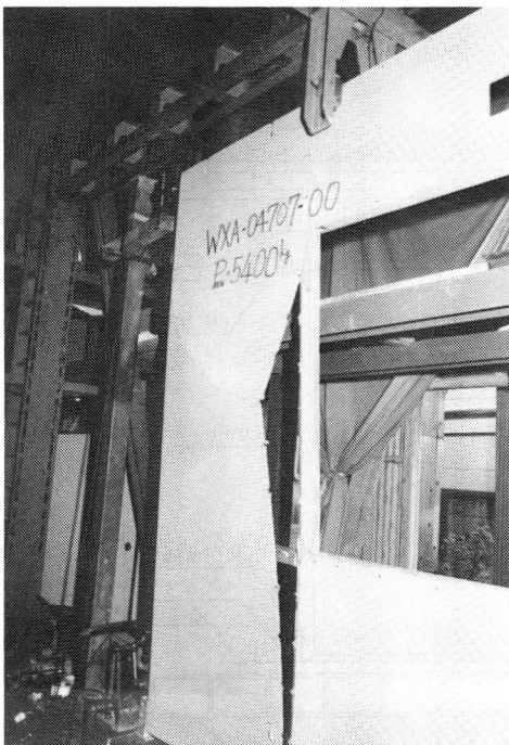
写真-2 破壊状況
