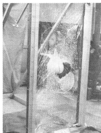
写真-5 試験体記号 L-1501-A-3 の破壊状況
