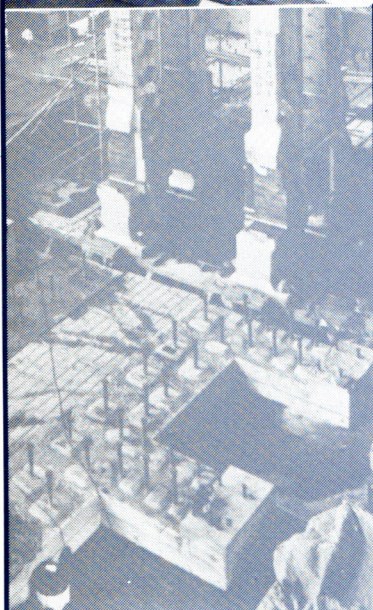
機械台座の施工例
