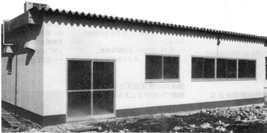
写真一 2 増築事務棟
