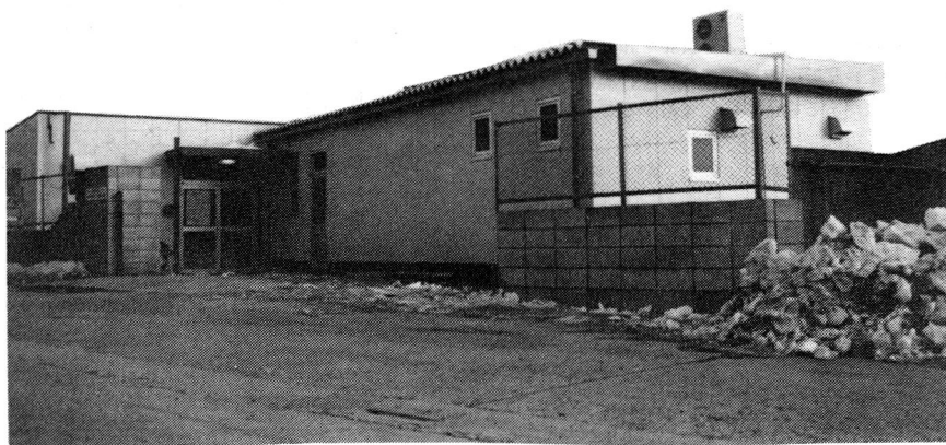
写真一 1 増築事務棟
