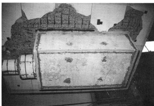
写真-8 試験体記号Aの試験後の炉内側の状況
