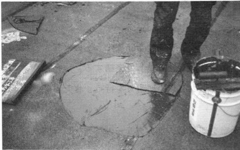
ハ. 常温アスファルトを塗布し,剥がした旧防水層を元に戻す。
