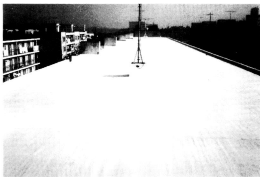
ポリマーセメントモルタル仕上げ
