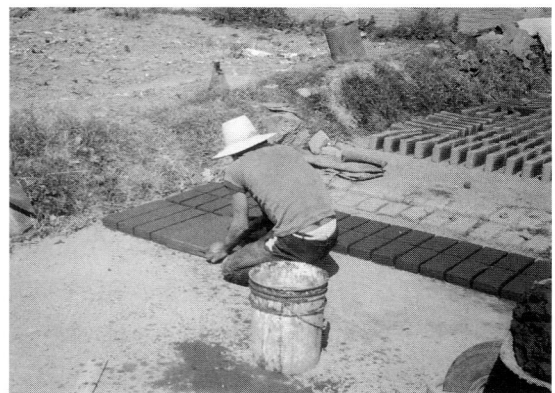
写真6 れんが製造工程④ 表面に水をかけ、手及びへらで慣らし脱型して終了。なお、1日はそのままの状態、次の2日間は縦にして天日で乾燥させる。
