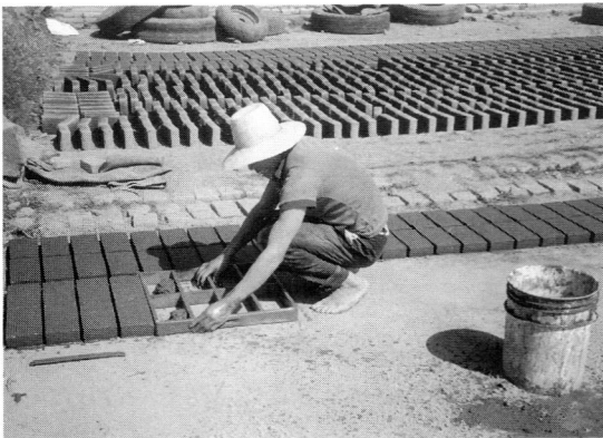
写真3 れんが製造工程① 木製型枠の設置
