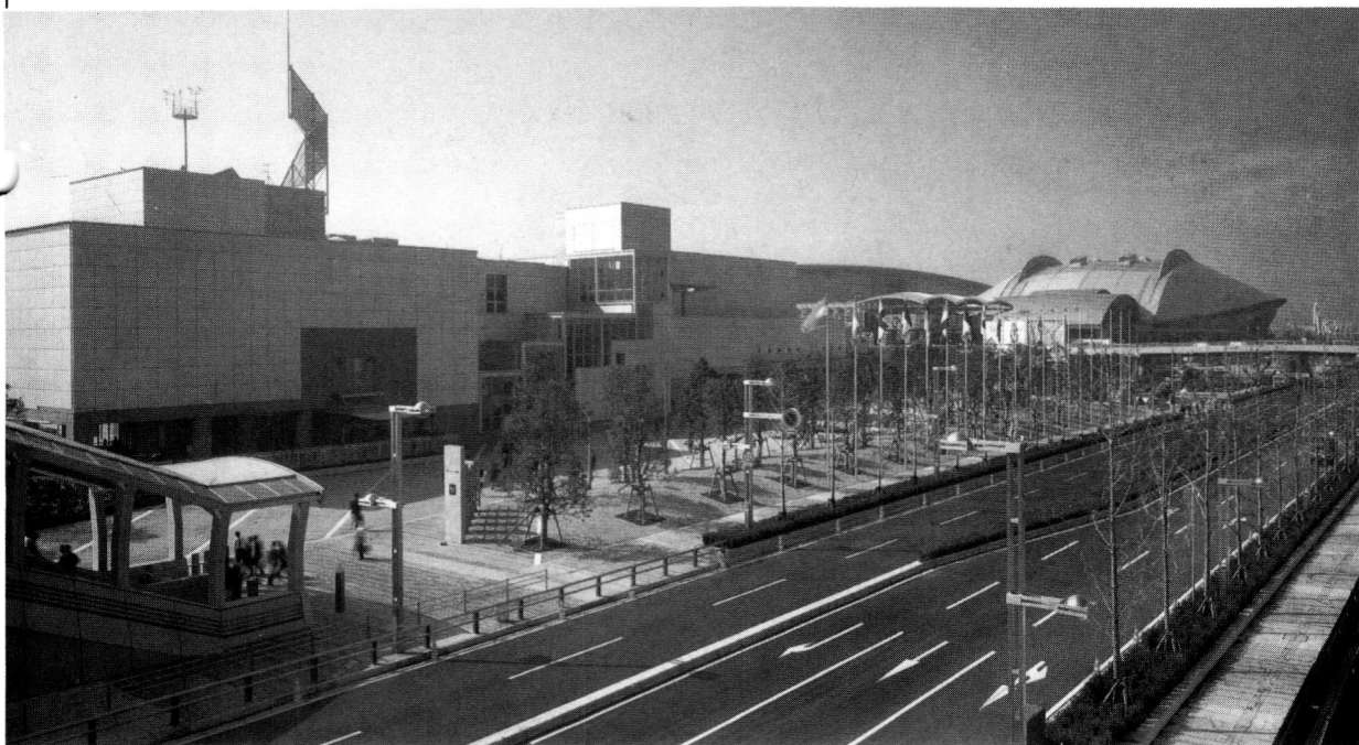
日本コンベンションセンター(幕張メッセ)・外壁アクアシール塗布
