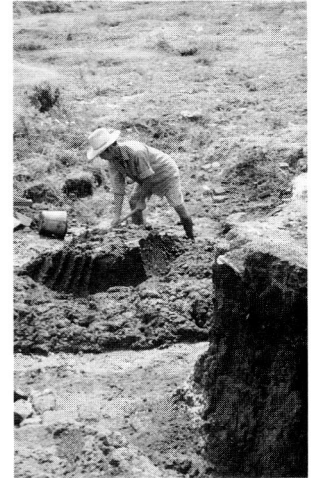
写真8 粘土のミックス状況
