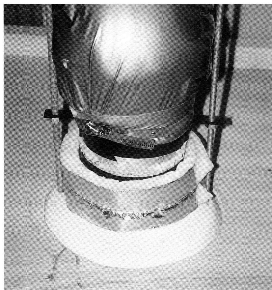
写真2 試験体記号Aの小屋裏側の設置状況
