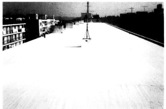
ポリマーセメントモルタル仕上げ
