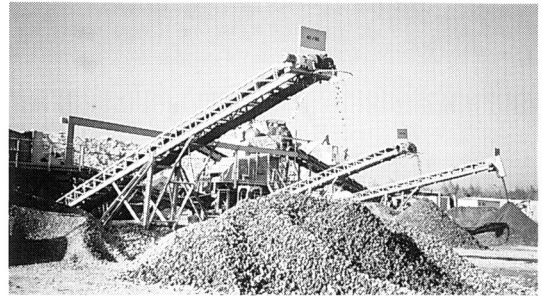
再生骨材製造プラント
