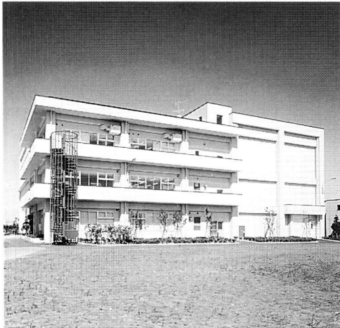
燃焼実験棟“B”
