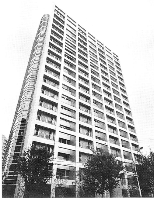
写真2 インテグラルタワー大林外観
