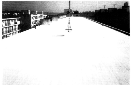
ポリマーセメントモルタル仕上げ
