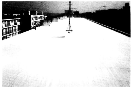
ポリマーセメントモルタル仕上げ
