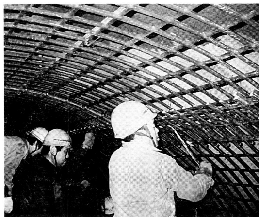
写真4 トンネルアーチ筋としての利用例
