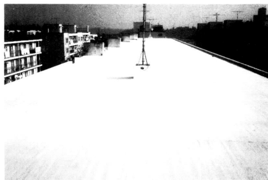
ポリマーセメントモルタル仕上げ
