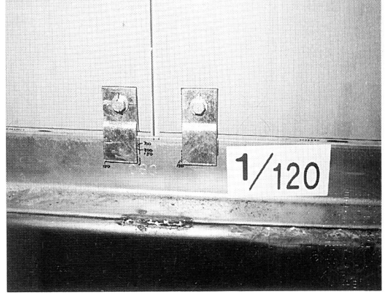
写真3 R_0 = 1/120 \text{ rad} の加振終了後の状況 (パネルの移動進展)
