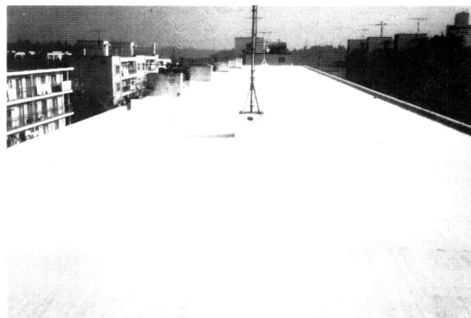
ポリマーセメントモルタル仕上げ
