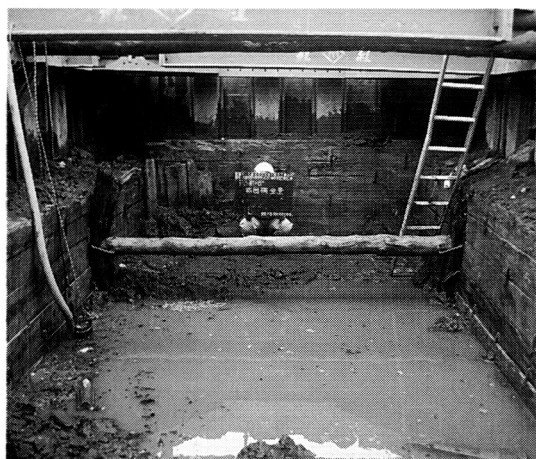
写真9 基礎の板掘削(箱枠)
