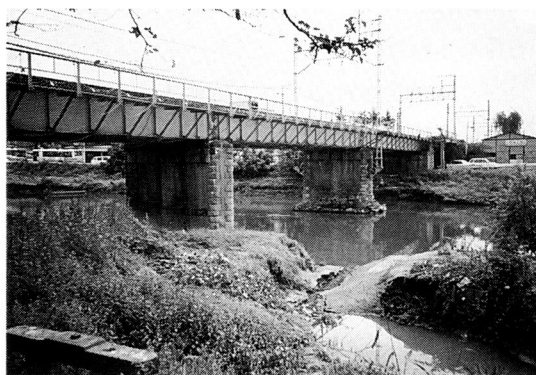
写真1 元荒川の橋梁全景
