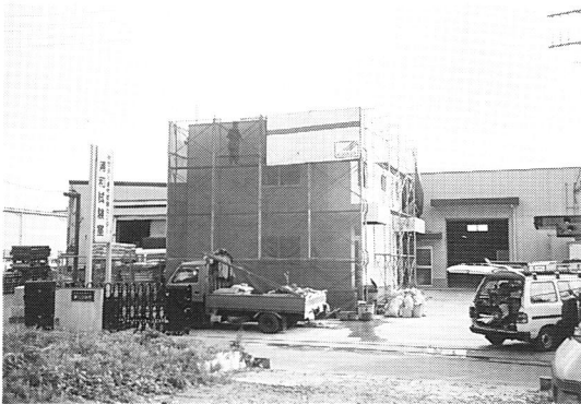
拡張工事が進む浦和試験室
