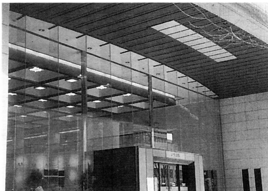
写真9 ガラススクリーンの被害がなかった例 (三宮地区)
