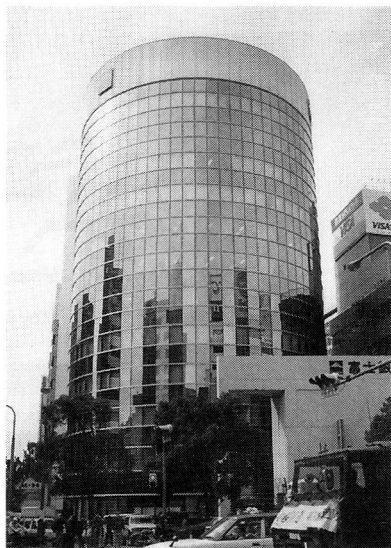
写真5 ガラスに被害のなかったカーテンウォール（三宮地区）
