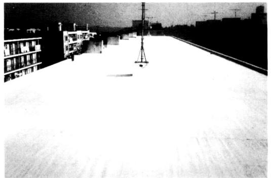
ポリマーセメントモルタル仕上げ
