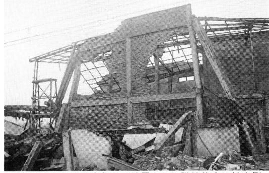
写真11 スマトラ南部リワ地震のRC2階建住宅の被害例
