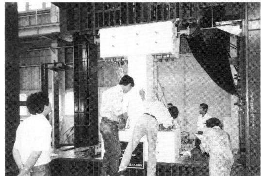
写真4 柱のせん断試験実施風景
