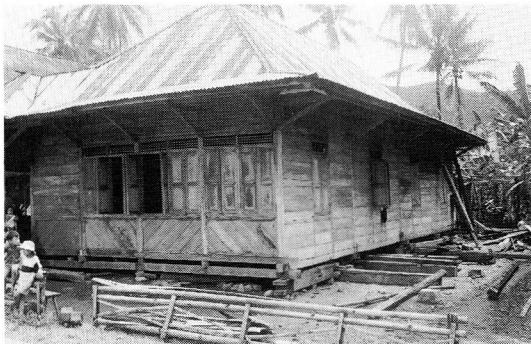
写真10 スマトラ南部リワ地震の高床式木造住宅の被害例
