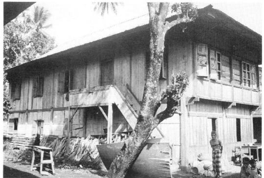
写真7 南スマトラの高床式木造住宅（支柱に木材を使用）
