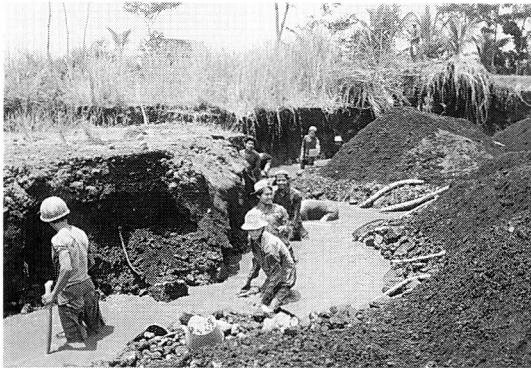
写真6 ジャワ島西部ガルングン山近くの砂の手掘り
