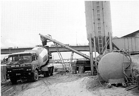
写真3 マーケット施工現場の仮設コンクリートプラント
