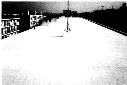
ポリマーセメントモルタル仕上げ
