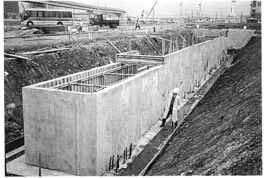
写真4 再生コンクリートを打設した地中梁
