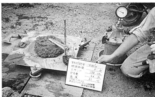
写真2 スランプ及び空気量の測定状況
