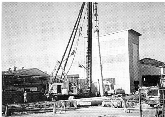
杭打ち工事のようす
