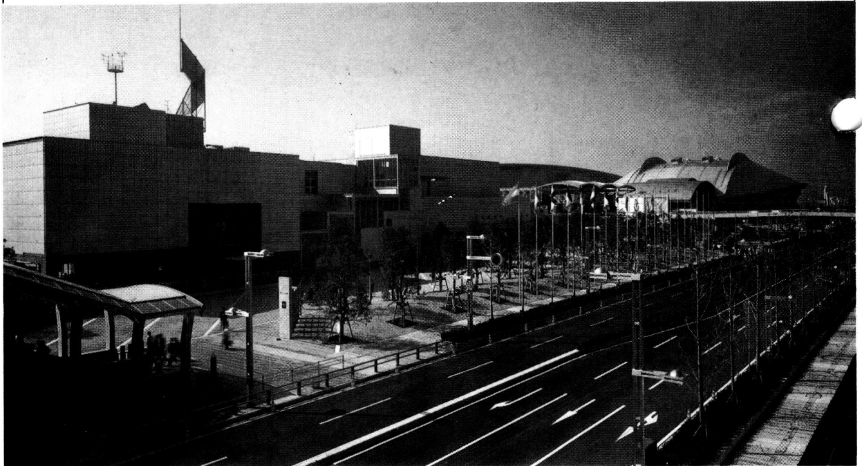
日本コンベンションセンター(幕張メッセ)・外壁アクアシール塗布
