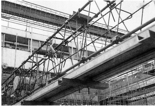
写真2 トラス鉄筋梁工法施工状況
