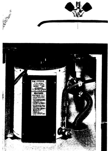
図8 電気温水器付き洗面化粧台
