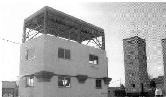
写真4 Hy Retro実証建屋及び地震観測建屋
