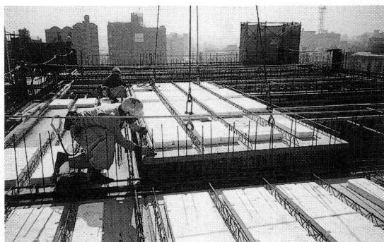
写真2 ハーフPCaボードの敷き込み
