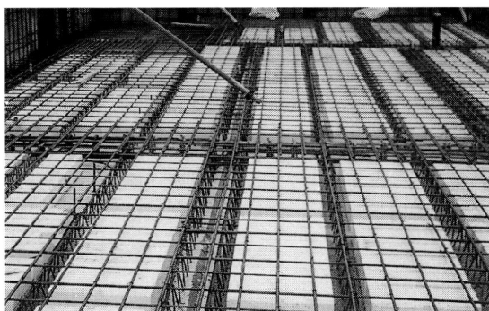
写真3 ボイドスラブの配筋
