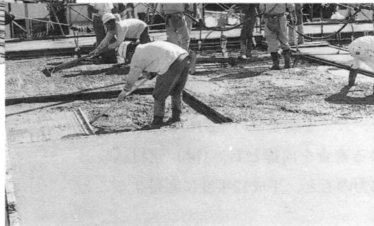
写真8 現場打ちコンクリートの打込み
