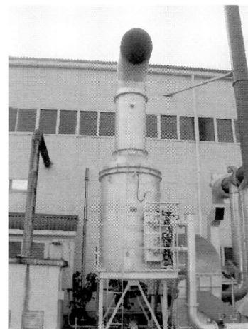
写真2 排煙処理装置
