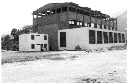
写真13 CISMID実験棟全景
