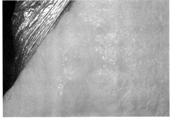
写真4 結露状況（袋内GW：試験体No.2）
