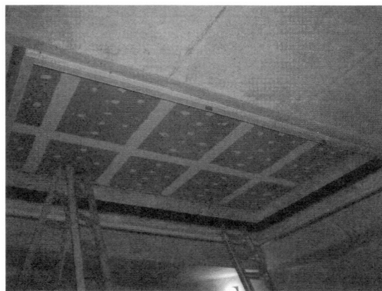
写真3 残響室3 (天井の施工)
