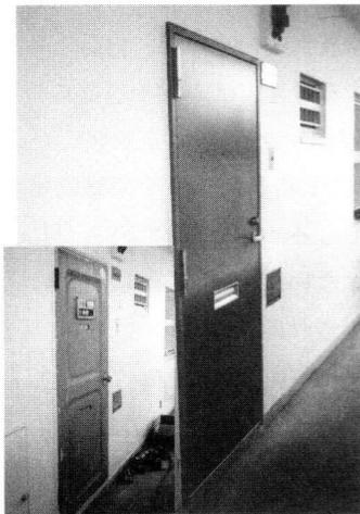
写真13 玄関扉の取り替え工事
