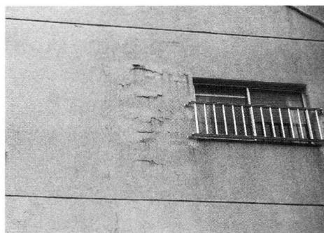
写真1 鉄筋腐食によるコンクリートの押し出し
