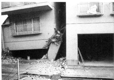
写真3 ピロティ形式の建物に被害
