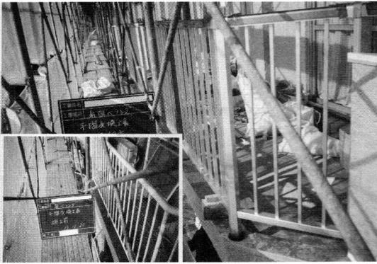
写真11 手摺りの取り替え工事
