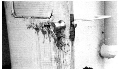
写真10 屋上出入口扉の腐食
