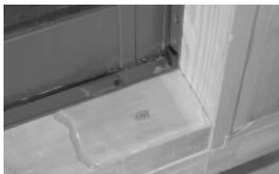
写真4 試験体2, 試験条件II, 圧力差350Pa (枠外)
