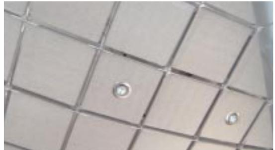
写真5 ポーラスガラスを吸音板として天井に施工
