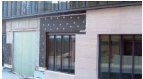
写真12 外断熱工法の現場（フランクフルト）
